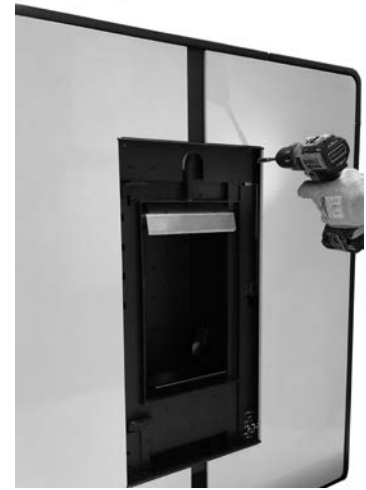
Fig. 41 - Bevestiging bekleding
