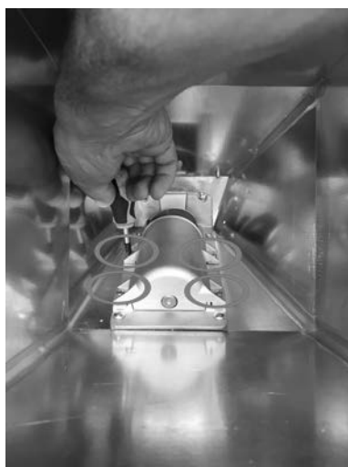
Fig. 49 - Verwijdering van de schroeven
