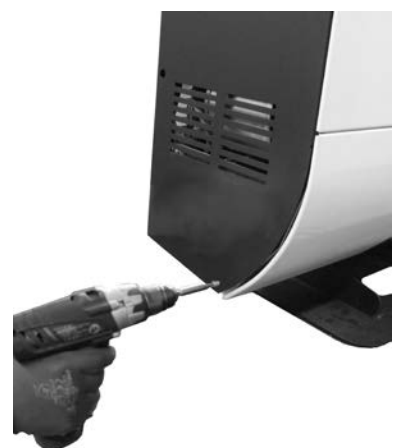
Fig. 33 - Bevestiging onderaan van de panelen
