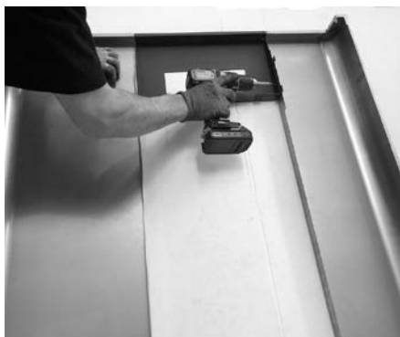
Fig. 31 - Fixação do montante
