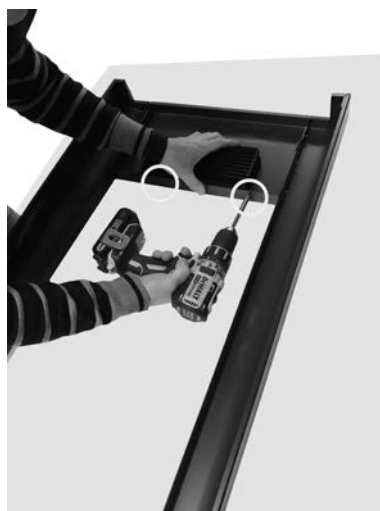
Fig. 12 - Fixação da grelha
