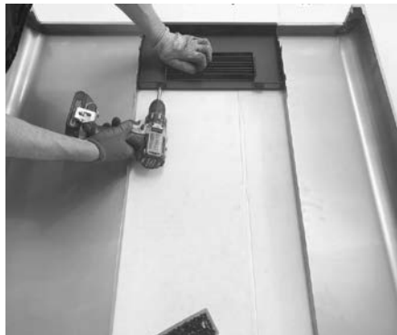
Fig. 32 - Fixação da grelha
