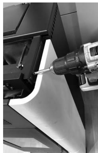
Fig. 27 - Fixação ao painel
