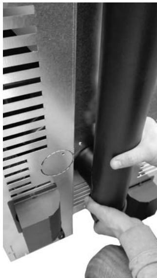
Fig. 55 - Przyczepić rurę o śr. 80 mm
