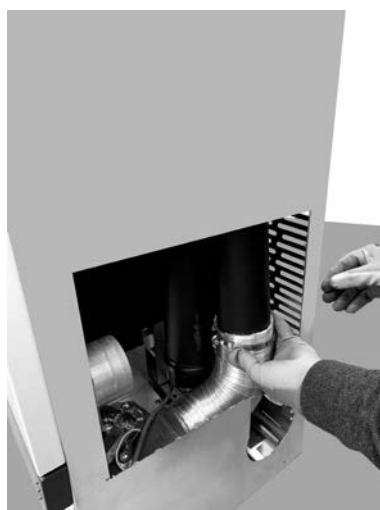
Fig. 83 - Połączyć rury
