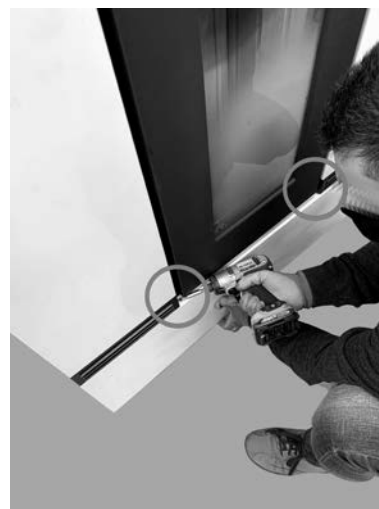
Fig. 44 - Przymocować dolną płytę
