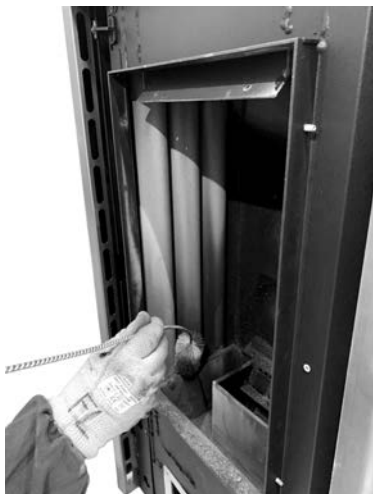
Fig. 102 - Wyczyścić szczotką do rur
