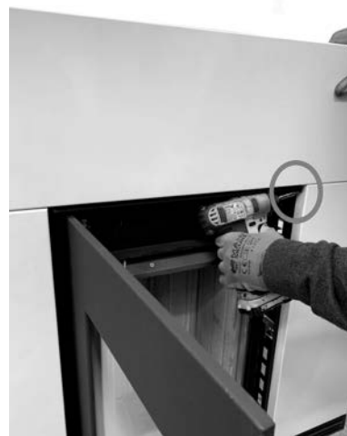
Fig. 41 - Przymocować górną płytę
