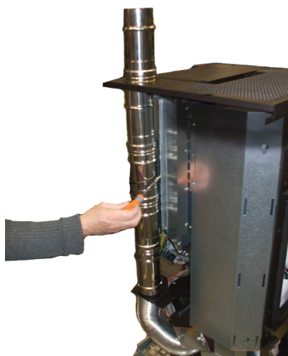
Fig. 56 - Układanie rur do górnego układu kanałowego
