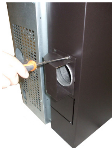
Fig. 69 - Montaż dyfuzora
