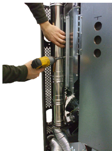
Fig. 64 - Mocowanie rury
